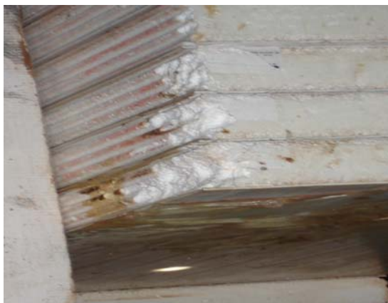
Foto 10:Paredes da câmara fria
