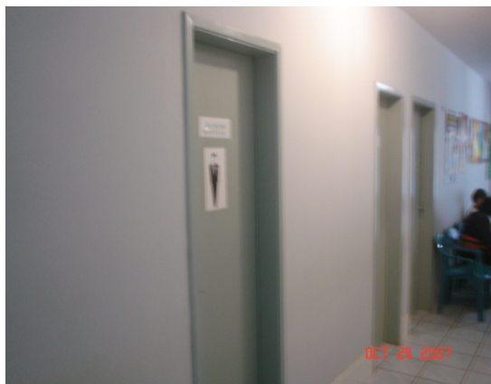
Sanitários no corredor da UBS.
