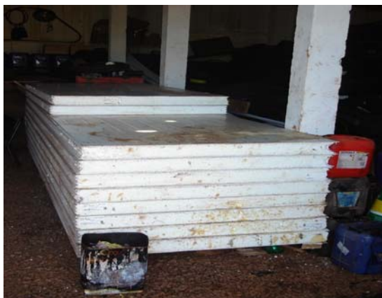
Foto 09:Paredes da câmara fria
