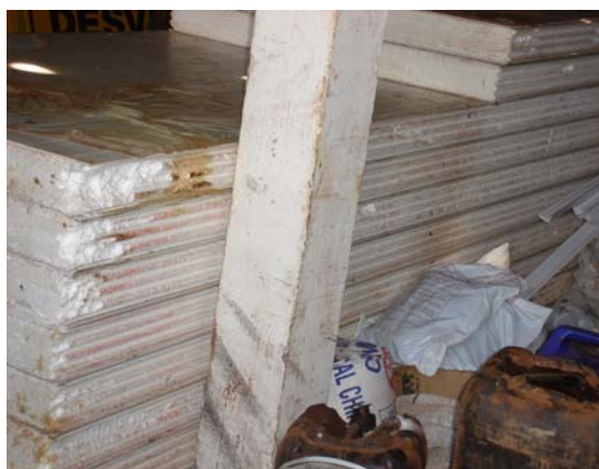
Foto 12: Paredes da câmara fria
