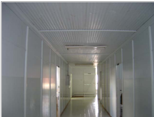
03 – Corredor interno da instituição, no qual foram executados serviços no forro e no piso.
