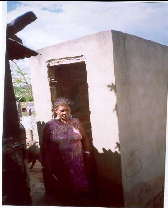
Foto 2- Beneficiário 98 da Relação. R Novo Horizonte, 25 Centro. Único banheiro que vimos com reboco, também inacabado.
