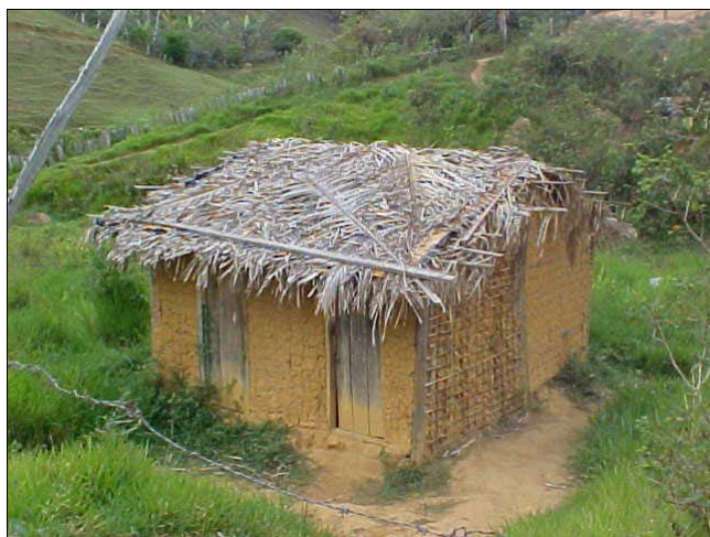
Foto 1 – Residência onde deveria ter sido construído módulo sanitário
