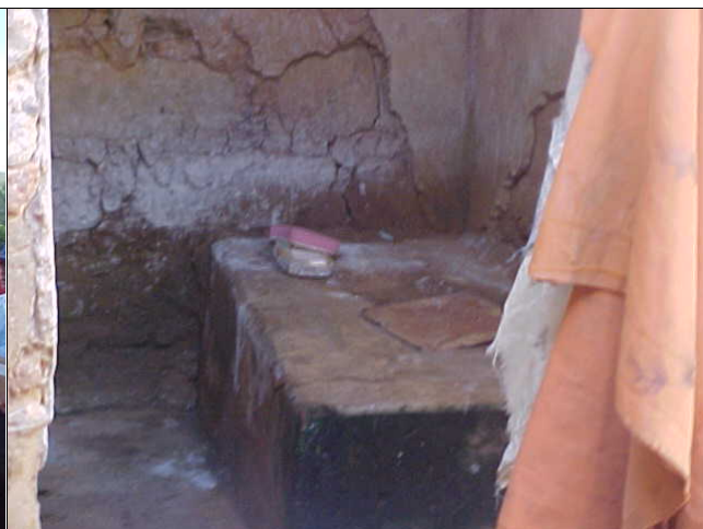
Foto 4 – Banheiro rústico pré-existente em residência que consta da relação de beneficiários
