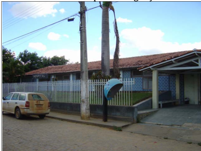
01 – Vista parcial do telhado do edifício do Hospital, destacando-se a parte reformada.
