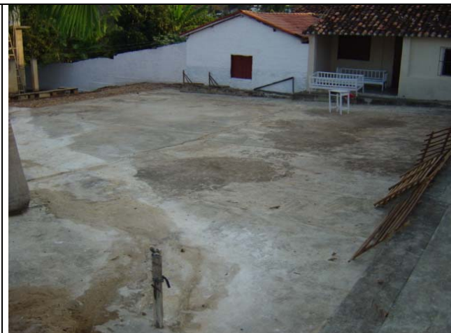
Foto(02) – Local do interior do Lote da creche, previsto para a construção da Unidade Escolar.
