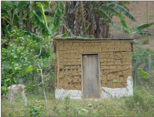
Foto 3 – Residência onde deveria ter sido construído módulo sanitário
