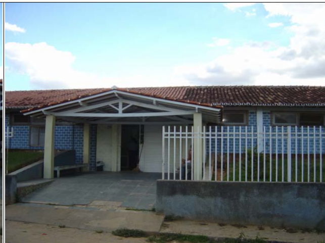
02 – Vista parcial do telhado do edifício do Hospital, notando-se a parte mais clara na qual foram realizados os serviços.
