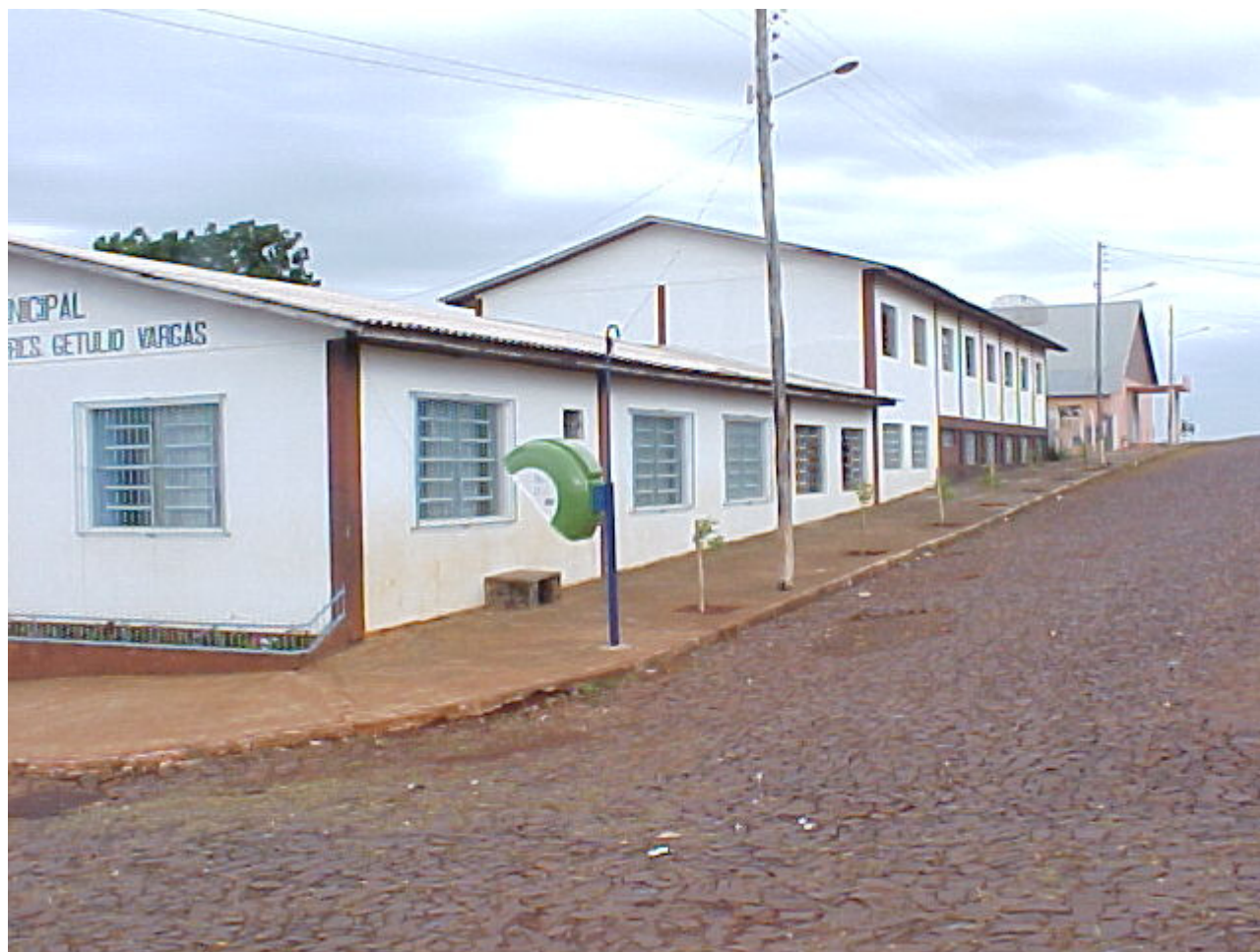
Foto 2: Escola Municipal Presidente Getúlio Vargas, onde foi construída a cobertura do ginásio de esportes.
