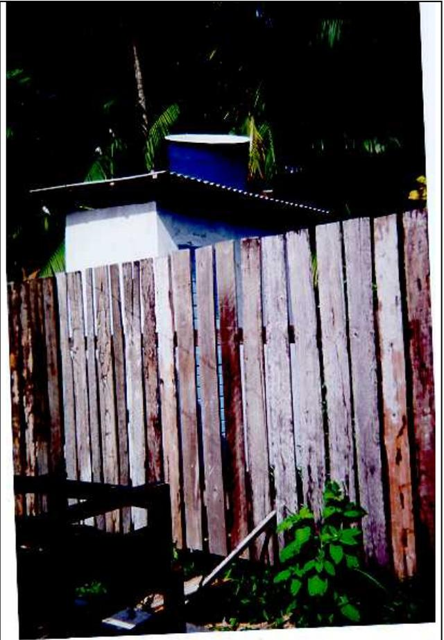
Foto 06 - Caixa d'água com risco de desabamento sem funcionamento.
