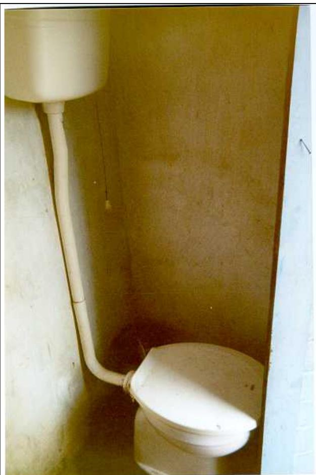
**Foto 04-Material de qualidade inferior ao orçado no Projeto (tampa do vaso sanitário )**
